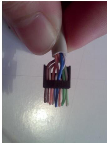
**Punto 7)** Coloque un conector RJ-45, con la lengüeta hacia abajo, en el extremo del cable con el par verde en el lado izquierdo del extremo T568-A, y el par naranja en el lado izquierdo del extremo T568-B.
