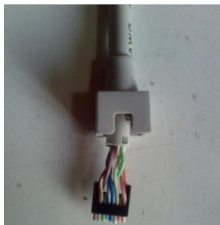
**Punto 6)** Coloque un conector RJ-45 en el extremo del cable, con la lengüeta hacia abajo y el par anaranjado en la parte izquierda del conector.
